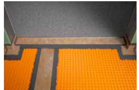
Schlüter-KERDI-CID met opgaande bekleding (afschot maximaal 6%)
