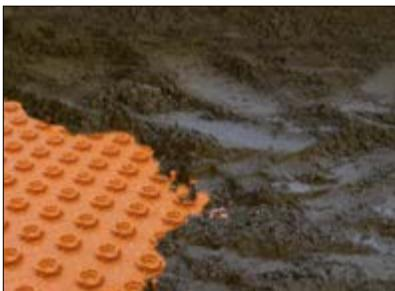
**14.** Einbau des Estrichmörtels ohne Bewehrung und Bewegungsfuge (Estrichgüte CA/CT-C25-F4, max. F5). Ausnahme: im Türbereich, mit Kellenschnitt oder Dehnfugenprofil Schlüter-DILEX-DFP sowie bei Bauwerkstrennfugen.
