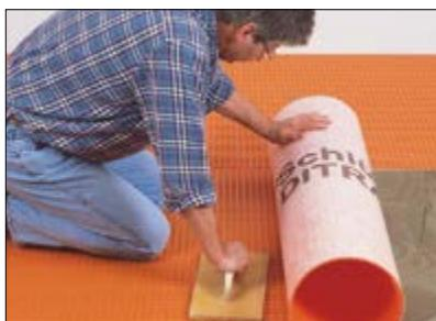
**17.** Für keramische Beläge/Naturstein: Verlegung der Verbundentkopplungsmatte Schlüter-DITRA in frischem Dünnbettmörtel nach Begehbarkeit des Estrichs. Bei Calciumsulfatestrich nach einer Restfeuchte von <= 2%.
