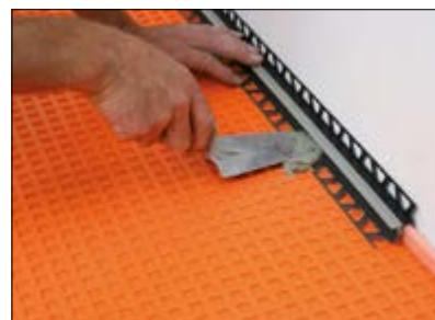
**19.** Einbau des Randbewegungsfugenprofils Schlüter-DILEX-EK bzw. -DILEX-RF.
