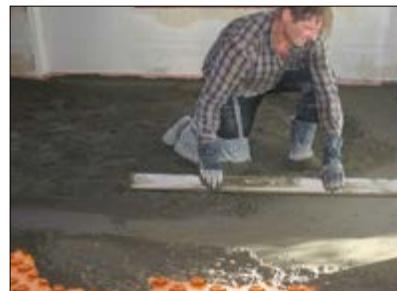
**15.** Abziehen der Estrichfläche mit einer Mindestüberdeckung von 8 mm. Höhenausgleich bei bereichsweisen Unebenheiten bis max. 15 mm Estrichüberdeckung (für nichtkeramische Beläge Datenblatt 9.5 beachten).
