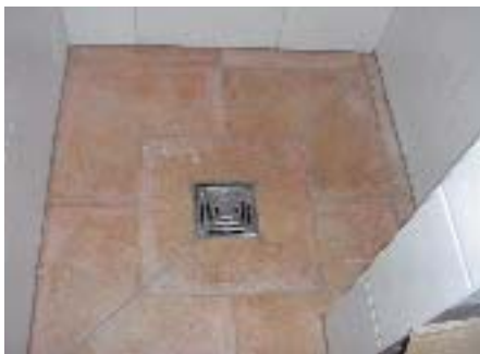
Voor de aansluiting op de waterafvoer werden vloeraflopen van het type KERDI-DRAIN gebruikt, die met hun aansluitflenzen een duurzame verbinding met de afdichting garanderen.
