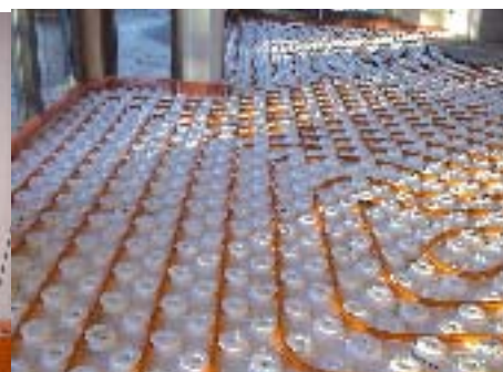
De opengewerkte noppen zijn op een zodanige wijze opgesteld dat de verwarmingsbuizen zich met een rasterafstand van 75 mm laten vastklemmen.
