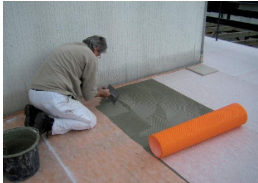
Schlüter-DITRA-DRAIN is een polyethyleenfolie met een speciale noppenstructuur; met op de bovenzijde een opgelijmde water- en dampdoorlatende capillair passieve filtervlies.
