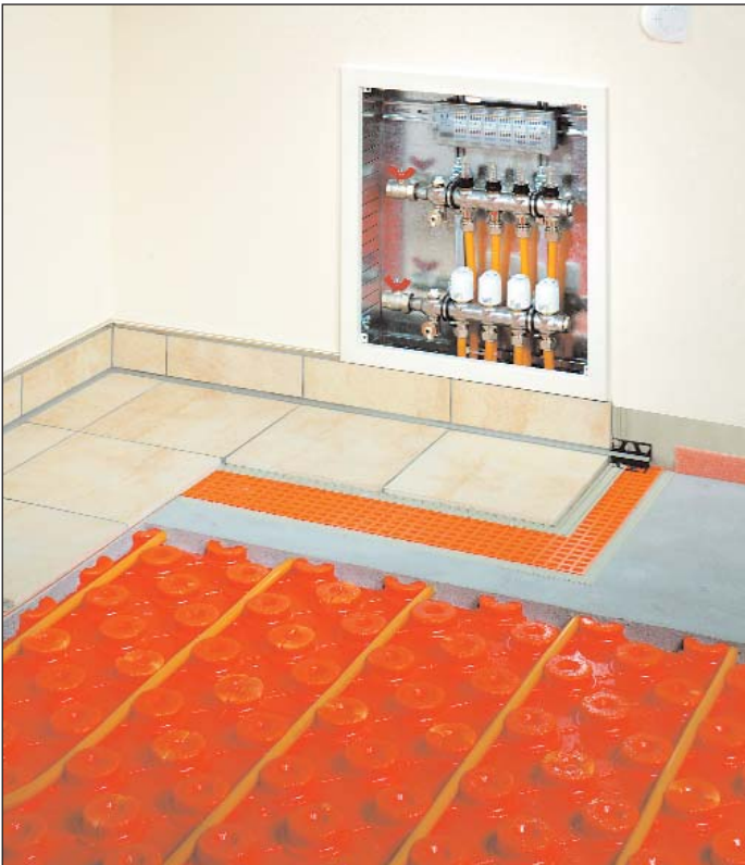
Van de noppenplaat tot de elektronische kamertemperatuurregeling: alle componenten van Schlüter-BEKOTEC-THERM zijn optimaal op elkaar afgestemd (doc. Schlüter-Systems)
