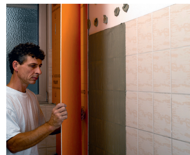
Een 5 mm dikke plaat voor het uitvlakken over oud tegel- en stucwerk heen.
