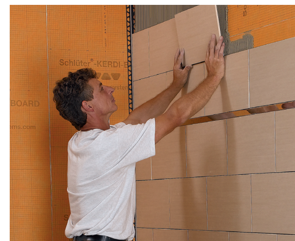
De samenstelling van de deklaag levert een goede hechting met met dunbedmortel.
