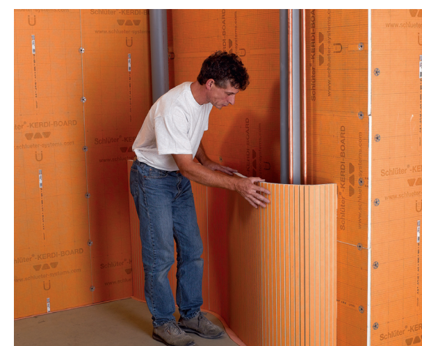
Met de voorgesneden varioplatten Kerdi-Board-V kan leidingwerk worden omkleed.
